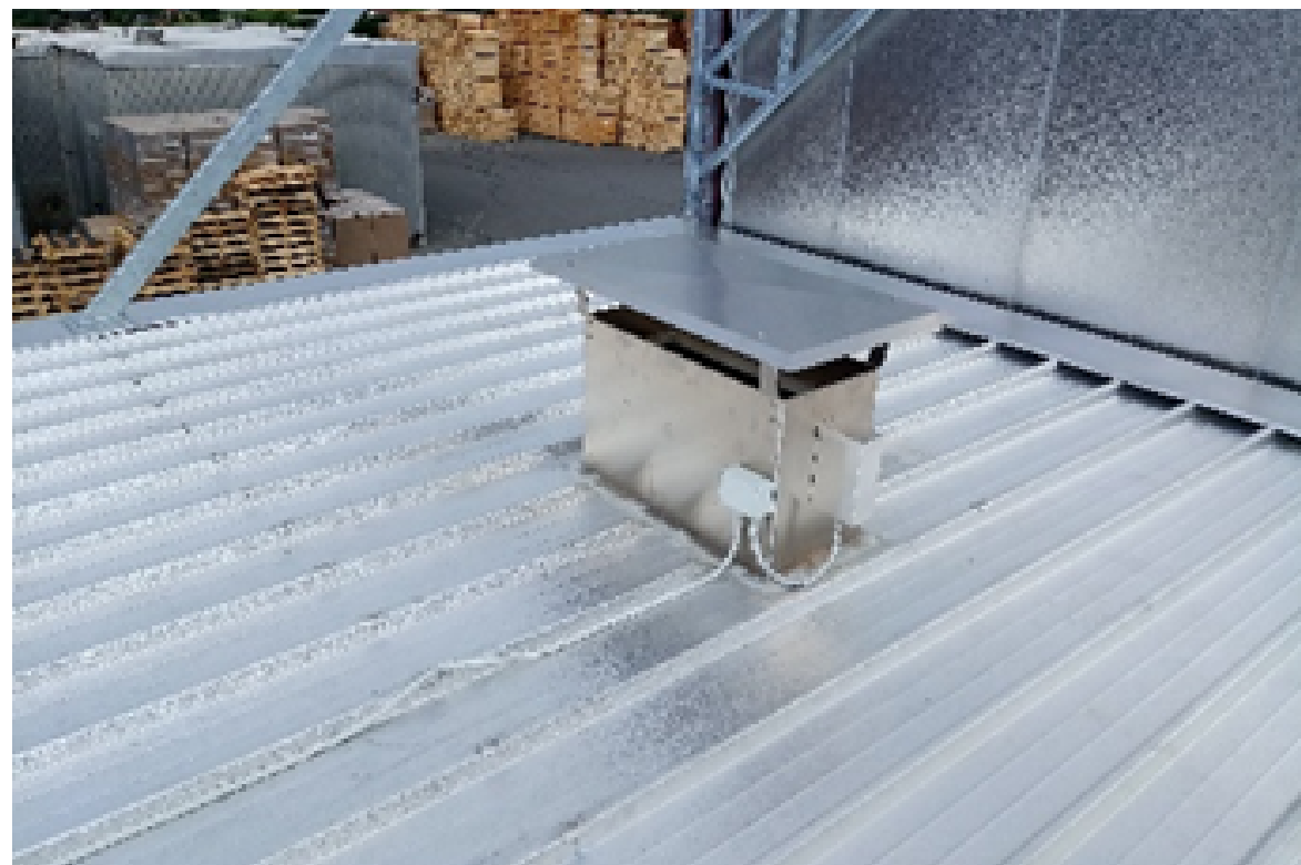
Камины ( на крыше)
